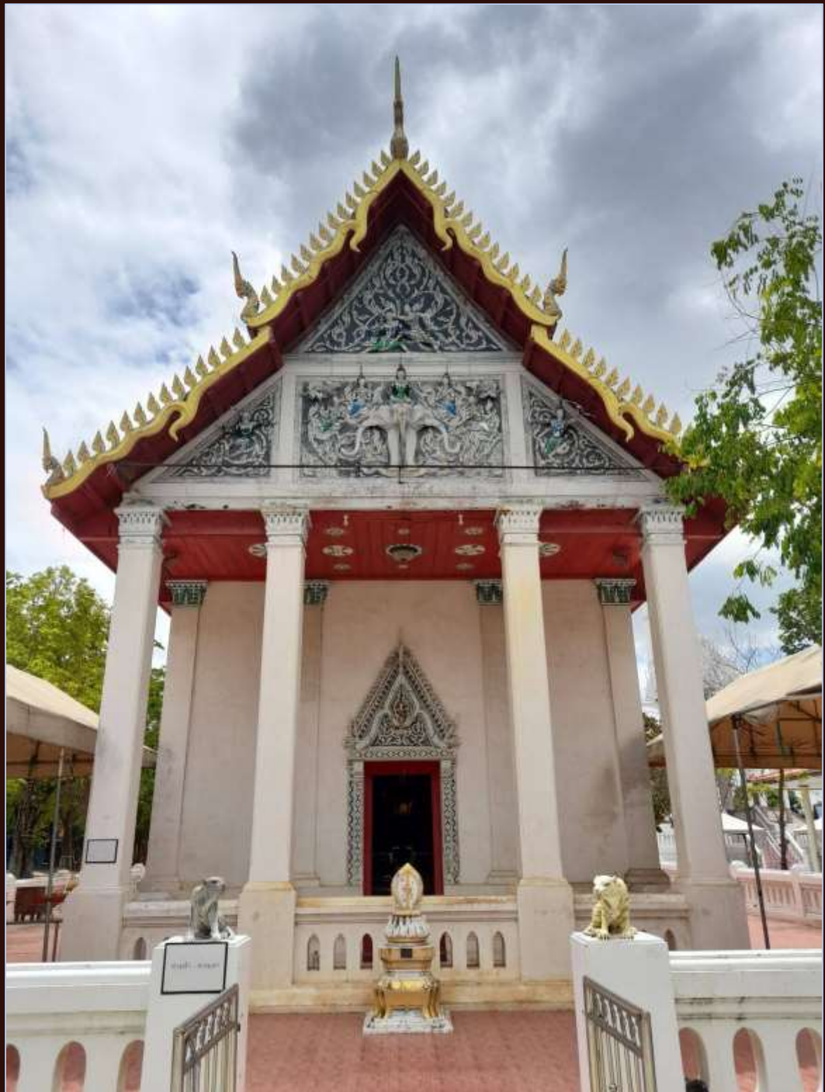
อุโบสถที่หลวงพ่อสรางเมื่อ พ.ศ. ๒๔๕๘
